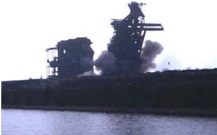
**Abb.6: Sprengung eines Hochofens**
